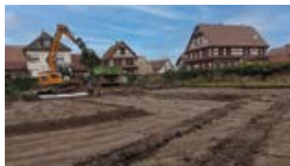
Démarrage chantier Terrassement 15 octobre 2024
